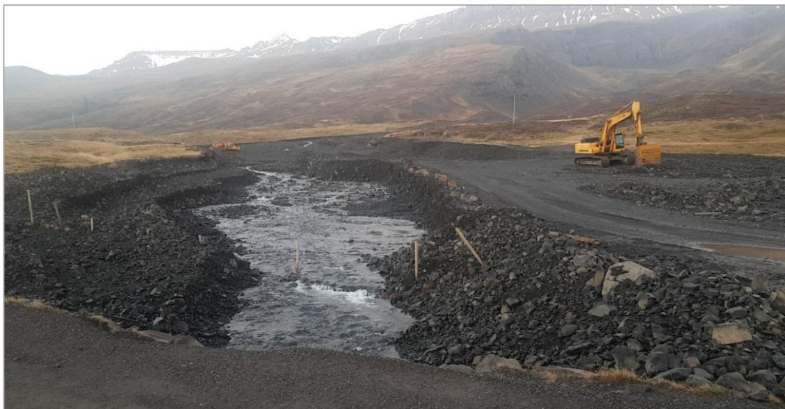
Mynd 8. Horft upp eftir farvegi Svartagilslækjar frá Hringvegi (mynd: Vegagerðin 19. nóv. 2018).
