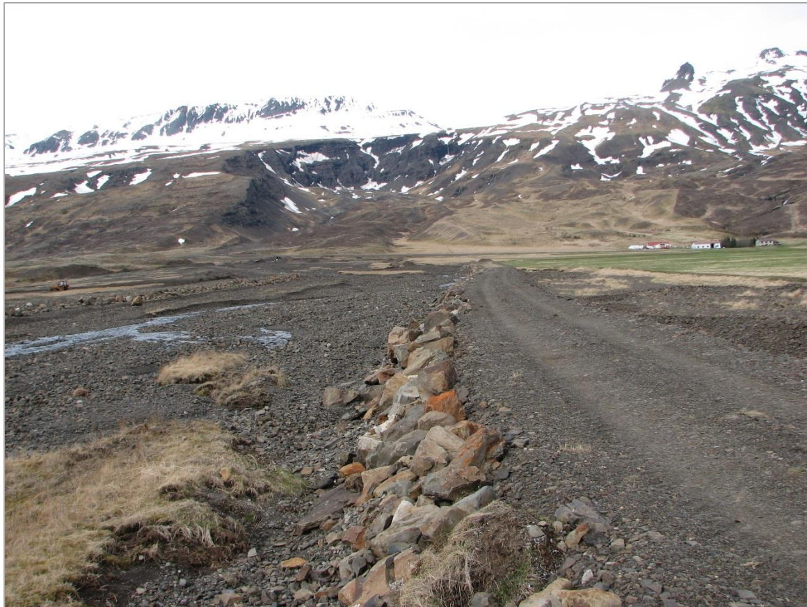
Mynd 7. Horft upp farveg Svartagilslækjar að austanverðu í átt að Hvannabrekku (mynd: Vegagerðin 2009).
